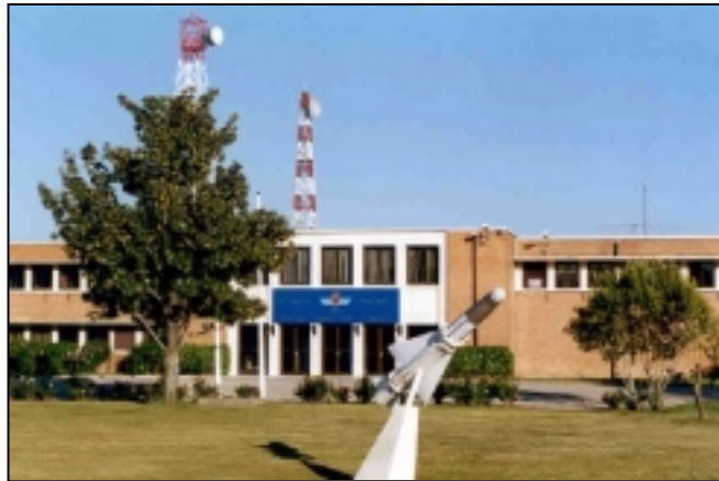
Foto 4: Edificio del Mando Aéreo de Combate (MACOM) en la base aérea de Torrejón. (Foto V.J. Ballester Olmos).
